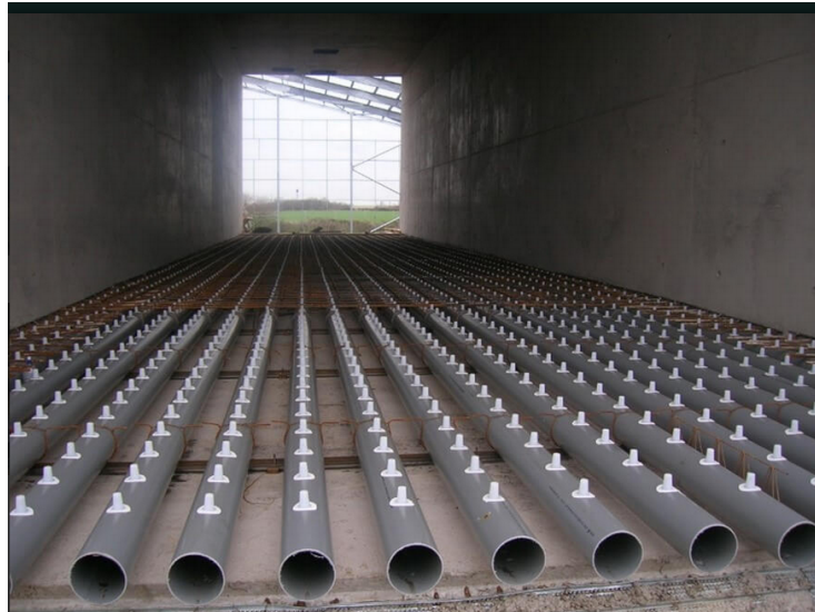
شکل 4 - 19 تصویری از لوله های خوابانیده شده در کف بونکر
